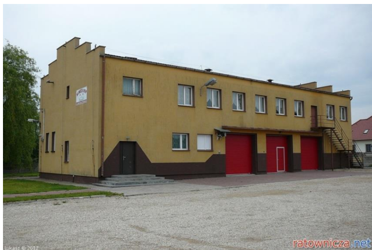
Zdjęcie 14. Budynek OSP w Kobielach Wielkich.
