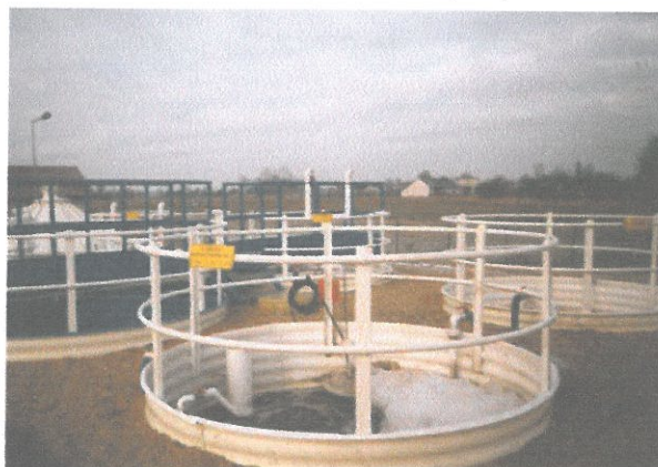
Zdjęcie 7. Oczyszczalnia ścieków w Kobielach Małych. Komory napowietrzania.
